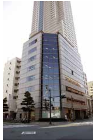
▲事務所外観 (上八丁堀ビル)
